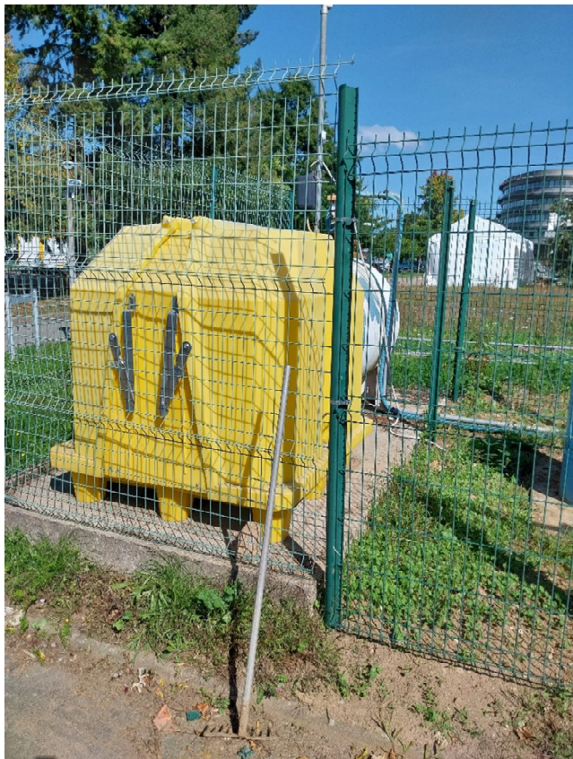
Figure 6 : Cuve de gazole et évent de respiration
