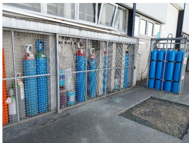
Figure 14 : Bouteilles de gaz dont des gaz inflammables dont certaines sont raccordées au réseau de distribution après détente
