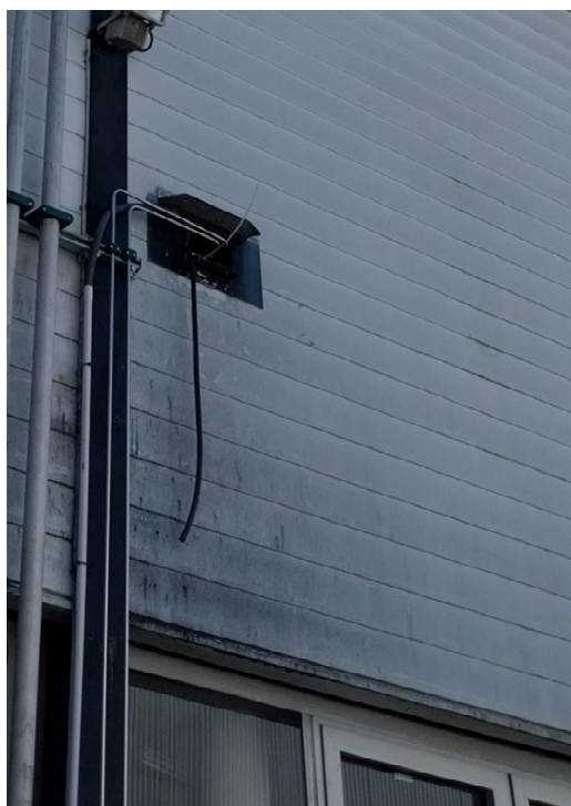
Figure 10 : Sortie d'évent sur la façade Nord du bâtiment
