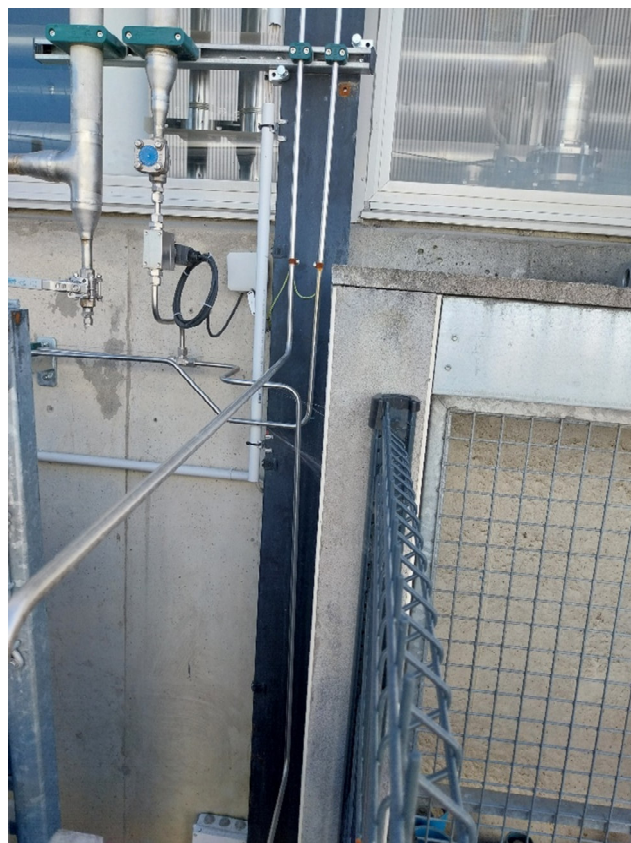
Figure 16 : Base des événements de purge du circuit hydrogène
