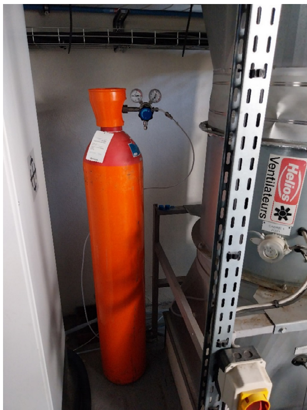
Figure 17 : Bouteille d'HELID-S (mélange contenant 40% d'hydrogène) dans le local des CTA
