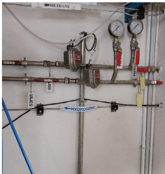
Figure 18 : Electro-vanne, vanne manuelle et baromètre sur la tuyauterie d'essence
