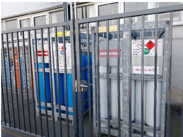
Figure 11 : Stockage des racks de bouteilles d'hydrogène au parc à gaz
