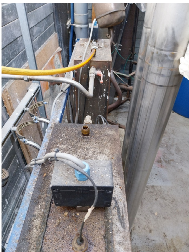
Figure 8 : Nourrices de carburants liquides en R+1 du local des bancs d'essai 4 et 5
