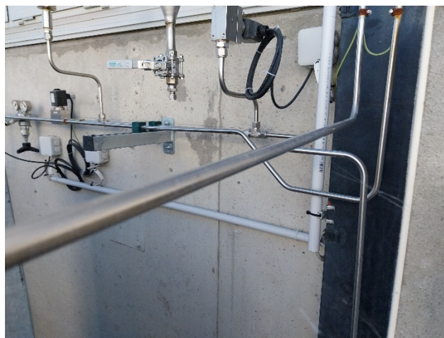
Figure 12 : Système de détente et distribution d'hydrogène depuis le stockage vers les installations utilisatrices
