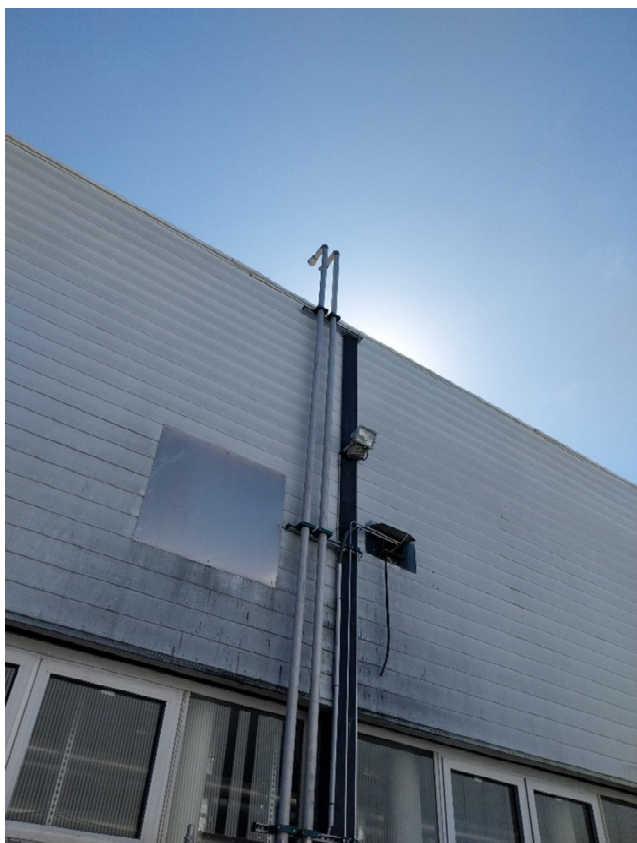
Figure 15 : Events de purge du circuit hydrogène
